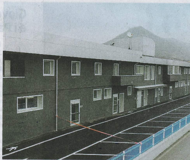
Lo stabile. È stata creata la mensa e lo spazio per la formazione
